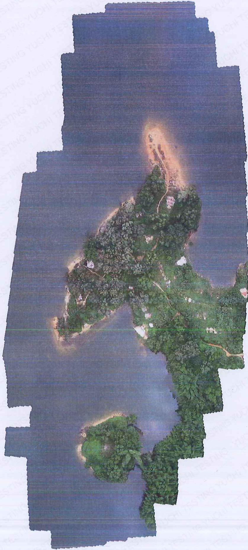
秋风水库调查点位无人机航拍正摄影像
