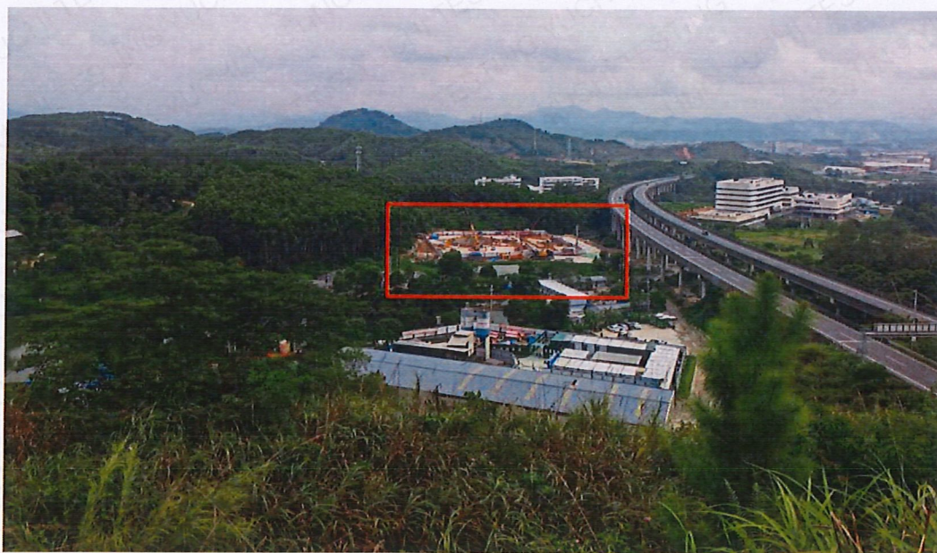
图 4.1-2 主干线 1 号施工支洞监测点新增施工区
