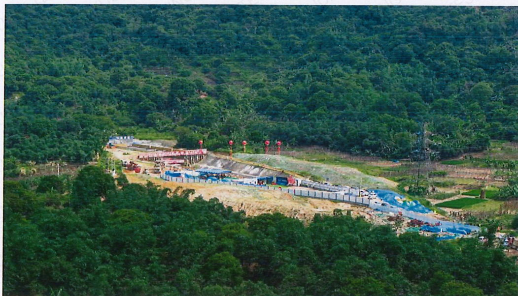
图 4.1-3 潮阳分干线穿生态保护红线区域新增施工区
