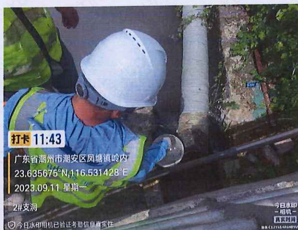
施工 1 标 2#支洞隧道洞口排水
