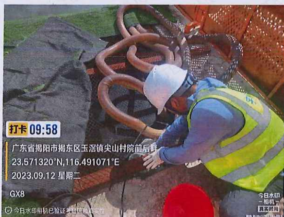
施工 2 标 GX8 生产废水
