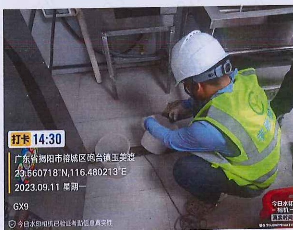
施工 3 标 GX9 厨房生活污水
