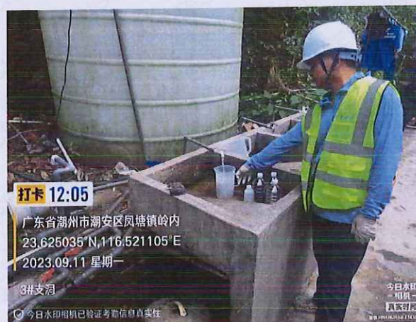
施工 1 标 3#支洞地下水井
