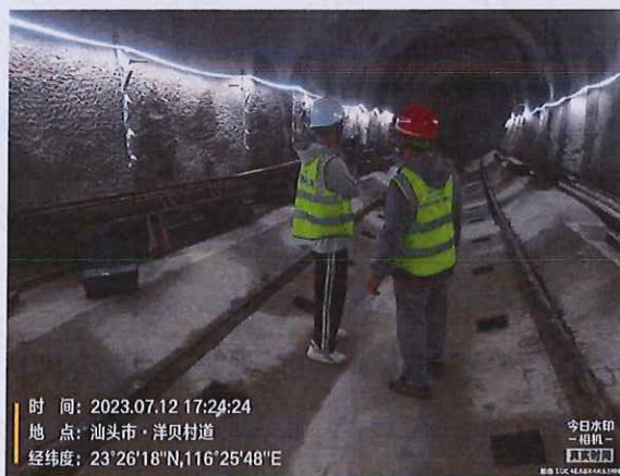
TBM 隧道洞口开端 100 米处
