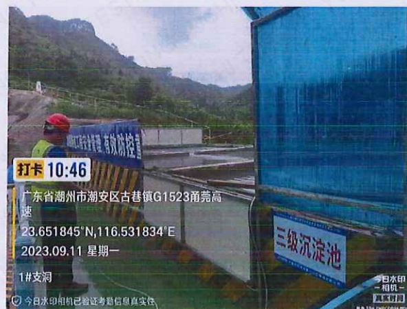
施工 1 标 1#支洞隧道洞口排水
