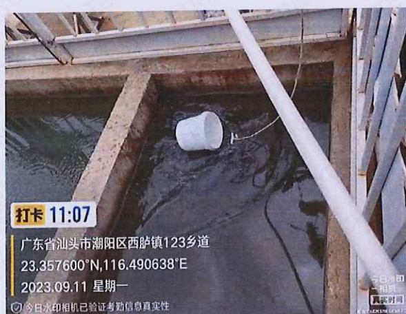
CYB08 顶管井生产废水
