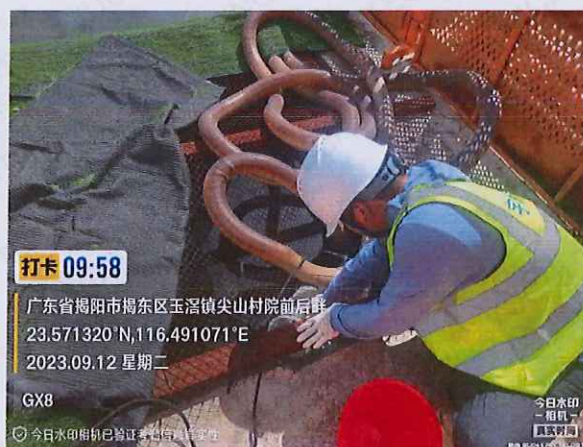
施工 2 标 GX8 生产废水
