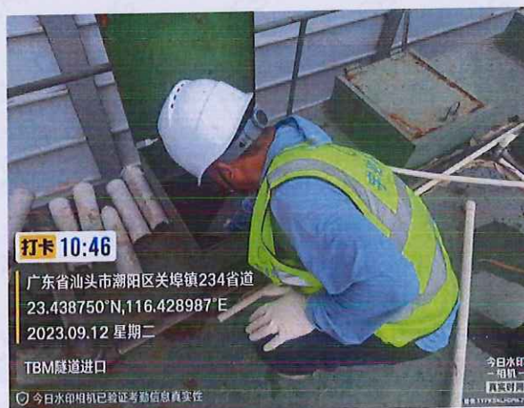
施工 5 标 TBM 进口生活污水
