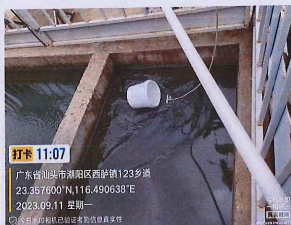
CYB08 顶管井生产废水
