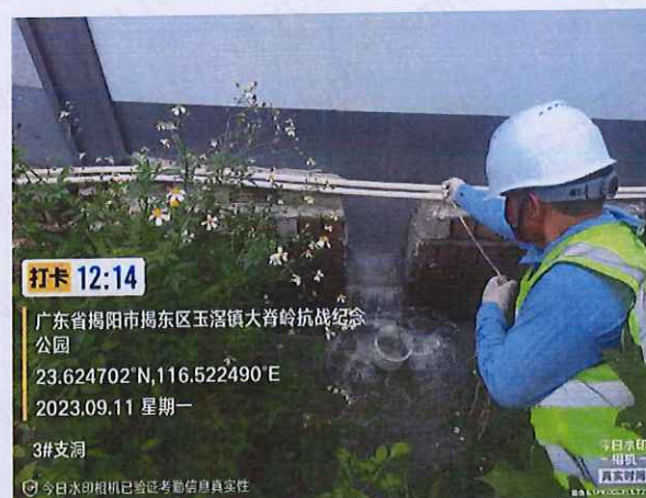
施工 1 标 3#支洞隧道洞口排水
