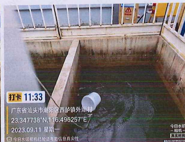
CYB09 顶管井生产废水
