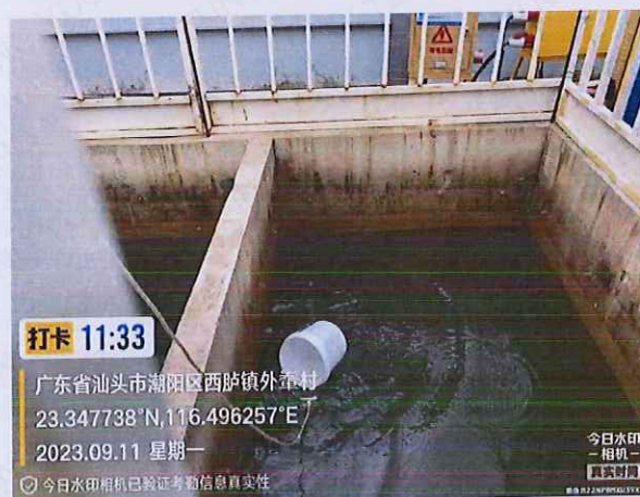
CYB09 顶管井生产废水
