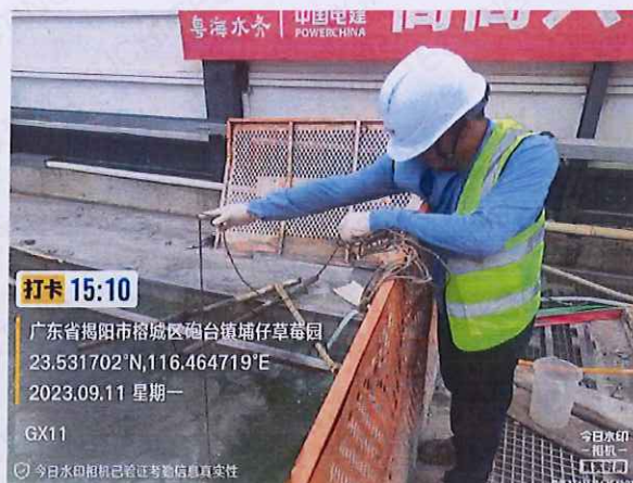
施工 2 标 GX11 生产废水
