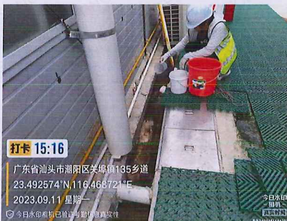
施工 4 标 GX13 厨房生活污水
