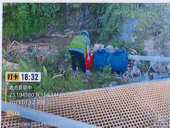
CN14 化粪池出水口
