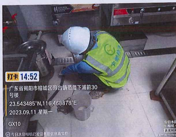
施工 3 标 GX10 厨房生活污水
