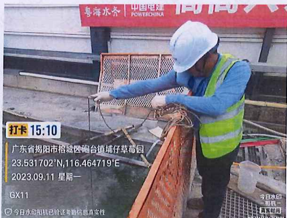
施工 2 标 GX11 生产废水
