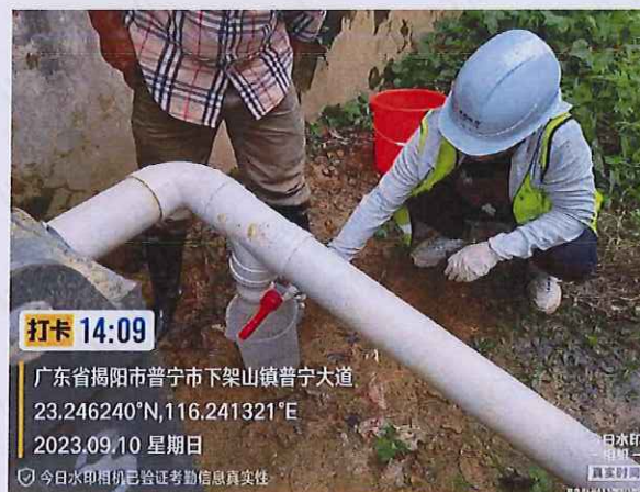
施工七标项目部厨房生活污水
