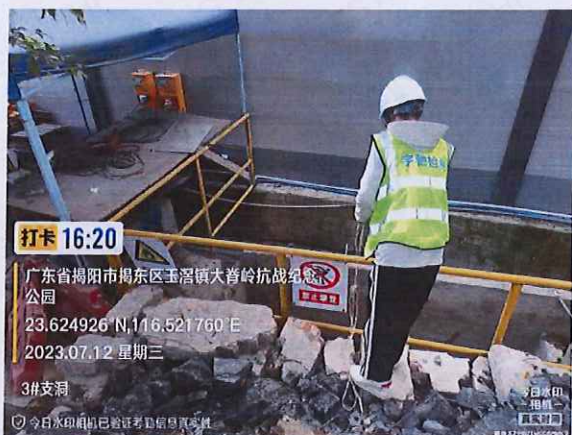
3#支洞生产废水
