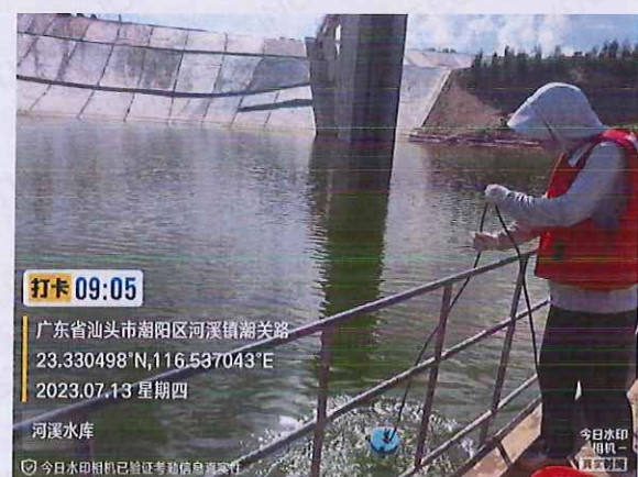
河溪水库取水口
